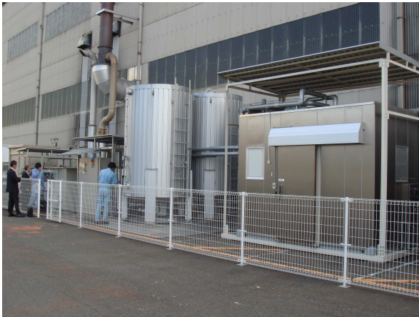
工場排熱を利用した MH 冷凍機のテストプラント
